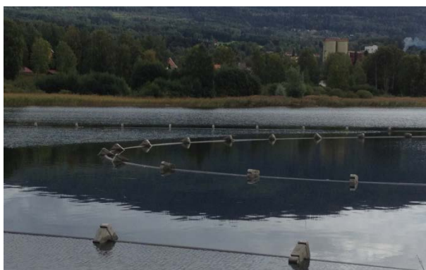
Sjøledning i Jarevatnet klar for senkning
