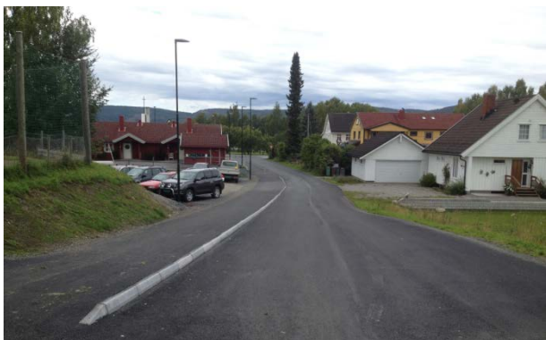
Nytt fortau ved Grymyr skole
