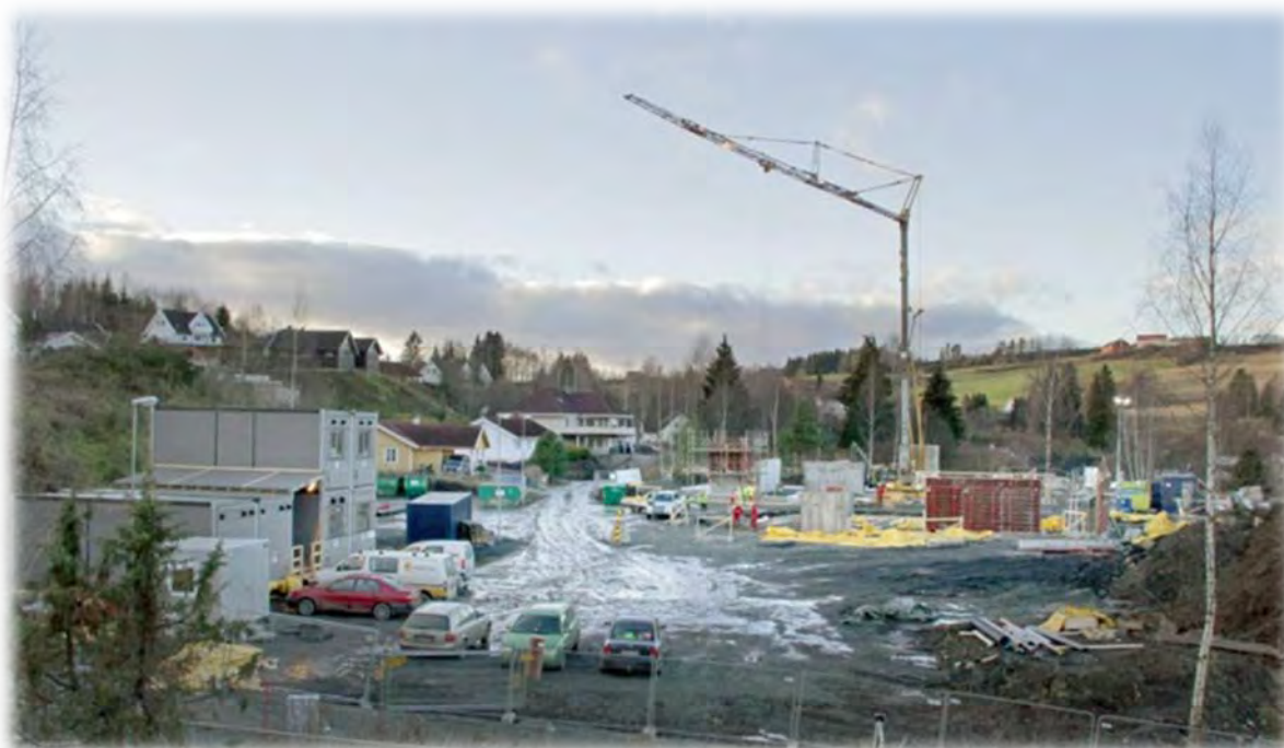
Markadompa: 16 omsorgsboliger forventes ferdigstilt i oktober 2016, innenfor tildelt ramme.
