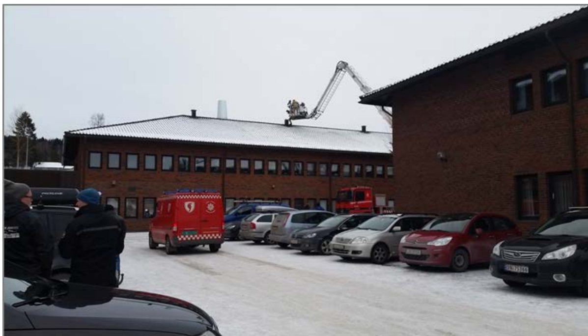
Brann på rådhuset i forbindelse med renoveringsarbeid vinteren 2017
