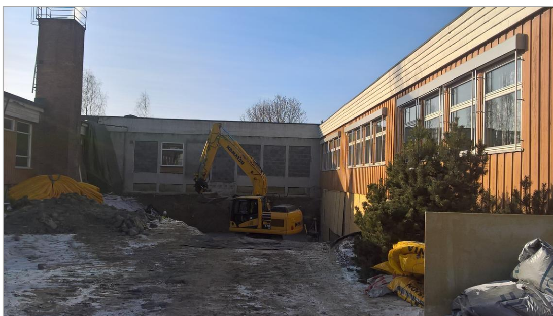
Brandbu ungdomsskole oppgraderes
