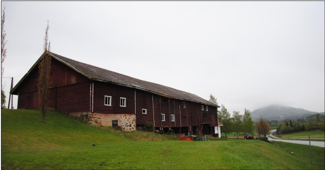
Fig. 26 Driftsbygningene framstår som store monumentale byggverk med lange tømmermannstradisjoner. Den store røde låven preger dagens gardstun og landskap. Samtidig er den et resultat av en driftsform som i hovedsak ble avviklet på 1950-60- tallet. Låvene er med sine dimensjoner og farger godt synlige og dominerende i landskapet. Her et eksempel på en staselig låve på Grinaker, som eiere har valgt å ta var på. Restaurering av taket på gråsteinsfjøset er støttet av Kulturminnefondet, mens det er gitt tilskudd fra Fylkesmannen i Oppland til oppretting og sikring av låven.
