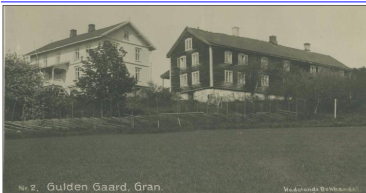
Fig.22 Gården Gulden med et stort flott våningshus som ble fredet i 1923. Bygningen har tre byggetrinn. Vestre del er satt opp i 1792, østre del er bygget i 1830, svalgang og utvendig panel kom i 1846. Et stort restaureringsarbeid er nylig utført. Prosjektet har fått midler fra Riksantikvaren. Foto: Hans Høgenes. Eldre postkort stemplet 1924. Hadeland bokhandel. Digitalt museum. Hadeland Folkemuseum.
