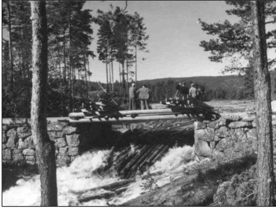
Fig. 18 Tømmerfløting foregikk i stor skala ved Bjonvassdammen i Bjonvassdraget, midt på 1960-tallet. Bjonvassdammen er en steindam fra 1891, men det har mest sannsynlig vært dam her tidligere. Dammen hadde kapasitet til ca 1500 kubikkmeter tømmer kunne passere i timen - tilsvarende ca 40 trailerlass. Fløtinga ble organisert av Østre Bjoneelvns Fellesfløtningsforening. Fotograf ukjent. Eier: Randsfjordmuseene
